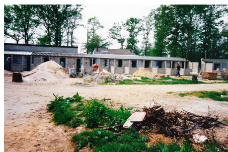
Construction de la deuxième travée de boxes
